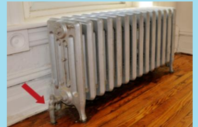
ระบบทำความร้อนรุ่นเก่าแบบแผ่นความร้อน (Radiator) และหม้อต้มน้ำ
