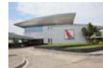
อาคาร Main Building และ Operation Building บมจ. บริการเชื้อเพลิงการบินกรุงเทพ
